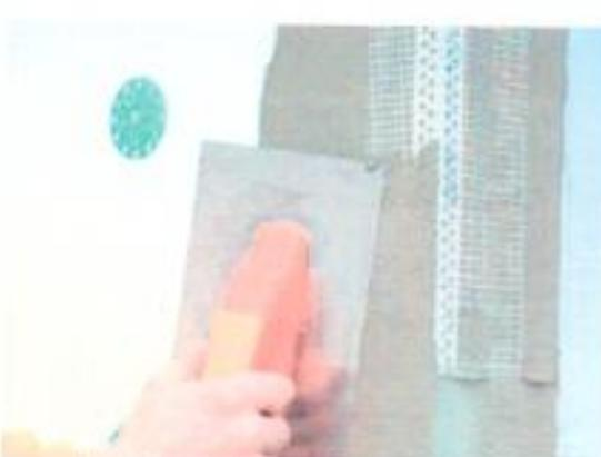
După uscare (24 de ore) masa de șpaclu se va șlefui fără deteriorarea plasei din fibră de sticlă, pentru nivelarea urmelor de la fierul de glet.
