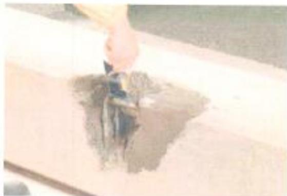
Mortar de reparații pentru beton - clasa R3
